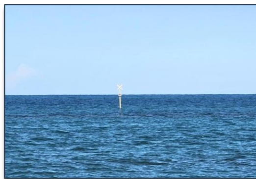
Figura 136: Baliza fija dique sumergido existente.
