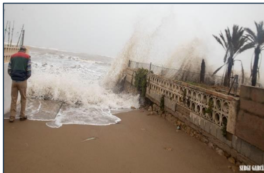
Figura 55: El temporal golpeando los muros en la zona del Blay Beach.
